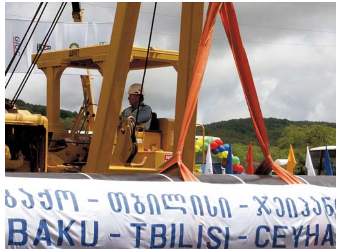
Das erste Rohr wird gelegt: Start der Bauarbeiten an der Erdöl-Pipeline von Baku nach Ceyhan. Sie wird mit US-Unterstützung gebaut und geht 2005 in Betrieb.
