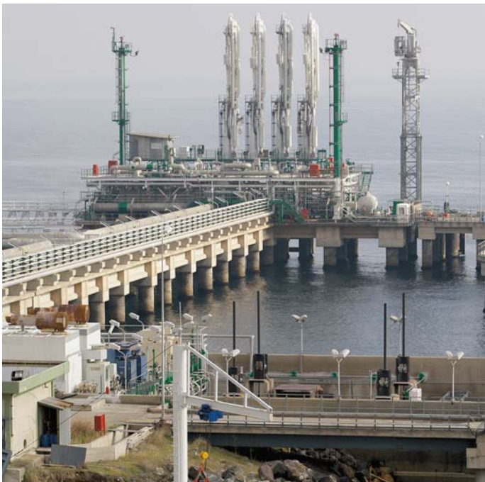
Flüssiggas-Import-Terminal des staatlichen Energieunternehmens BOTAŞ nahe der Stadt Tekirdağ. Sein bisher größtes Projekt, die Baku-Ceyhan-Pipeline, intensiviert die Energiebeziehungen mit Aserbaidschan.
